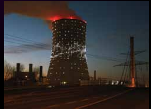
Electrabel Power Station, Bruxelles, Belgien. Foto: Magic Monkey.
